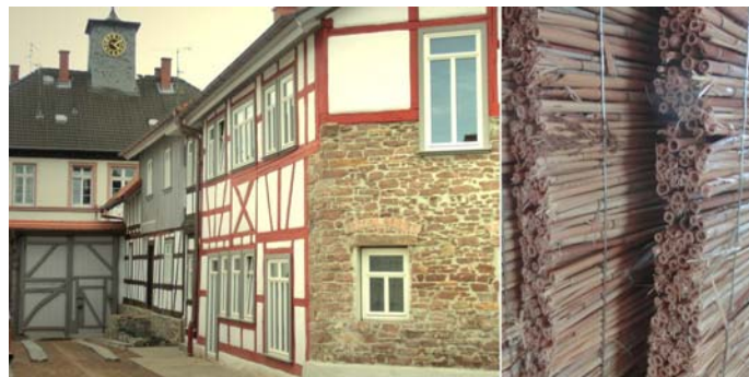
Bild: Ansicht der Gebäude von hinten mit Eingangstor (saniert), Wohnhaus (saniert), Verbindungsbau (neu) und Scheune (saniert zum Wohnhaus) sowie Schilfplatten zum Einbau © REG.eV
